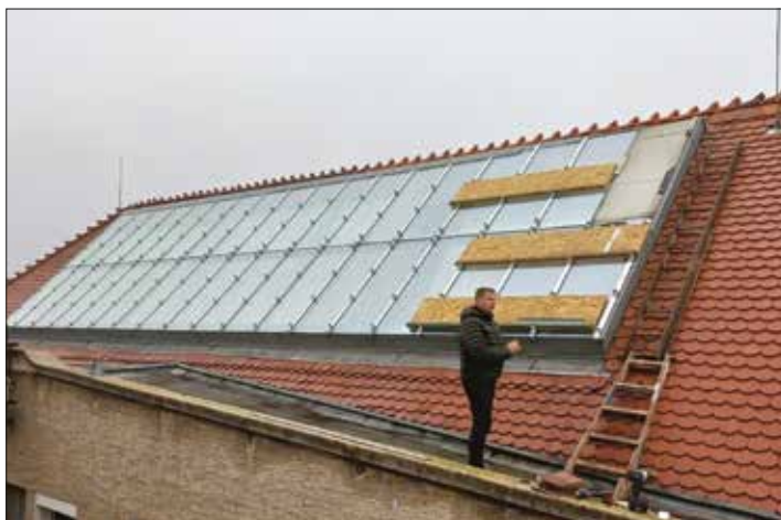
2.h. Főépület tetőrekonstrukciója: Az Auditórium Maximum feletti üvegtető, és az északi oldalon lévő timpanon felújítása
